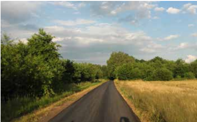
Inwestycje - remont drogi transportu rolnego.
