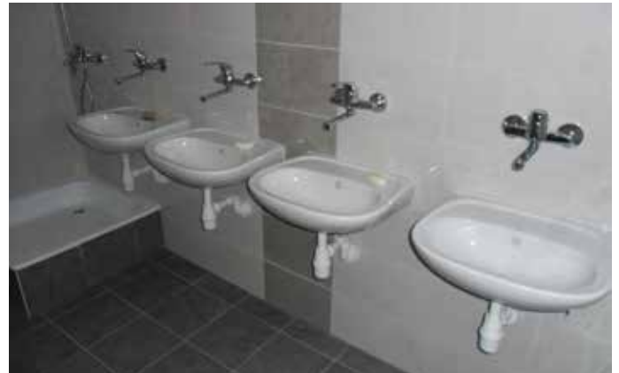
LZS Stare Koźle - remont zaplecza sanitarnego.
