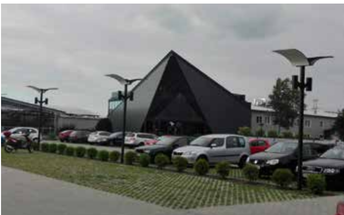
Siedziba firmy Spot-Light po remoncie.
