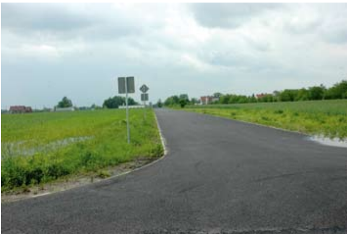
Nowowymbudowana droga do terenów inwestycyjnych w Starym Koźlu
