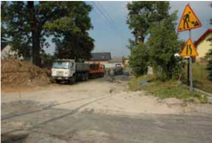
Bierawa, ul Sienkiewicza - odbudowa drogi po powodzi.
