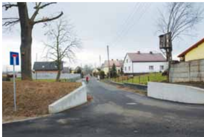
Bierawa, ul. Sienkiewicza - odbudowa drogi i wału
