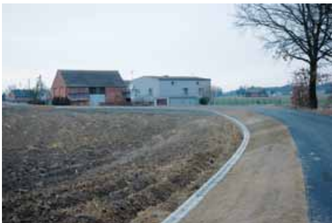
Stare Koźle - odbudowa wału po powodzi
