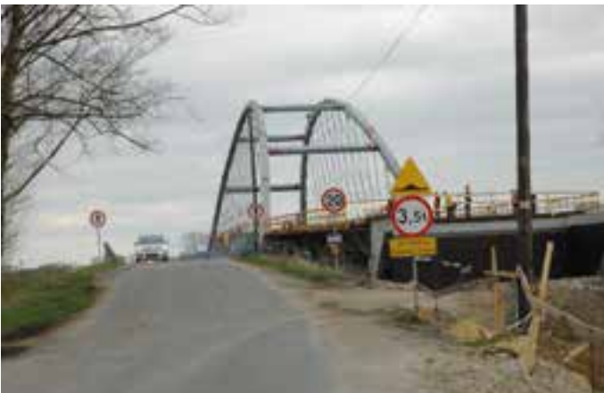
Budowa mostu Bierawa - Cisek
