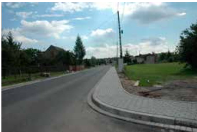
Budowa chodnika wraz z remontem nawierzchni w Bierawie
