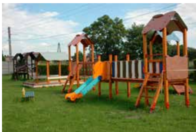
Budowa placów zabaw przy przedszkolach
